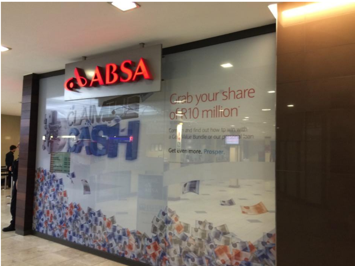
Auch hier ist die Sicht von außen nicht gewollt, wohl aber anders herum. In der gleichen Mall wurde perforierte Fensterfolie auch genutzt, den gläsernen Aufzugschacht zu verkleiden.
